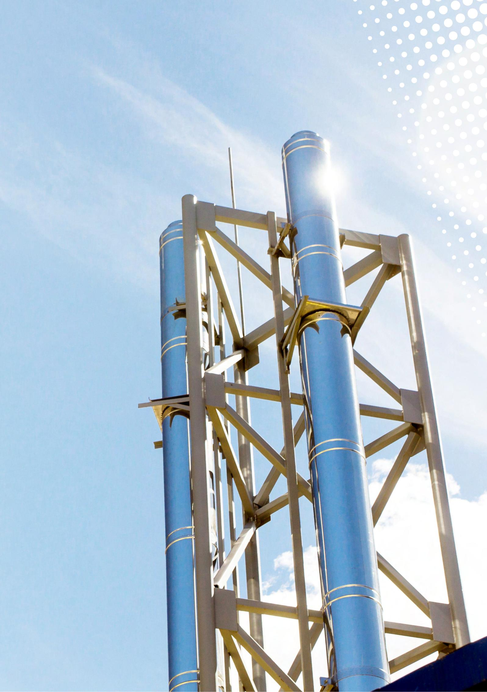
Промышленные системы дымоудаления – это комплексное решение, обеспечивающее отвод продуктов сгорания разных видов топлива. Кроме функции непосредственного отвода газа, дымоход обеспечивает должный уровень тяги, поддерживающий оптимальный режим работы горелочного оборудования.
